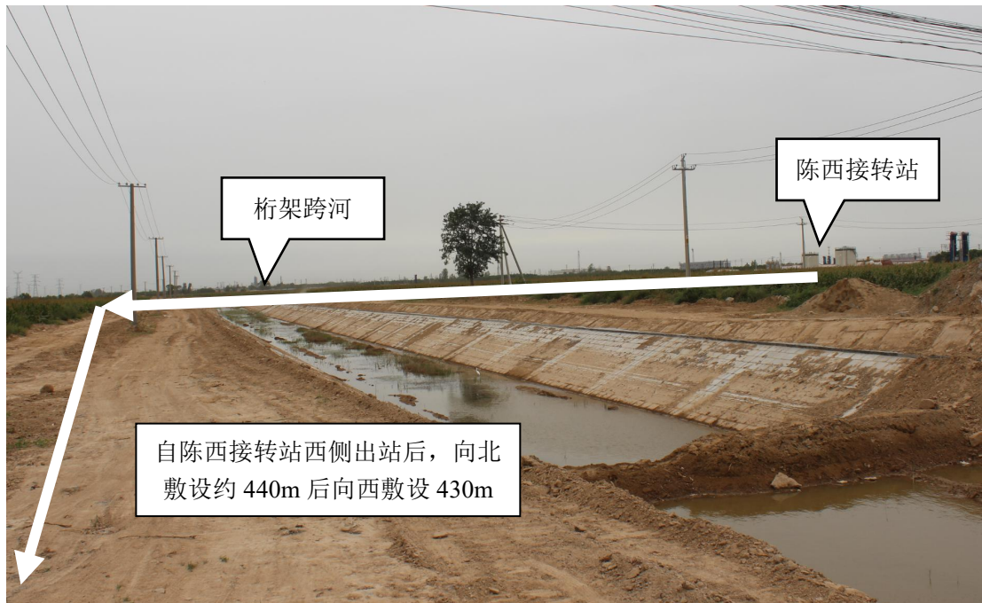
图 5.2-3 陈西接转站至陈 48#站掺水管线现场图 1
