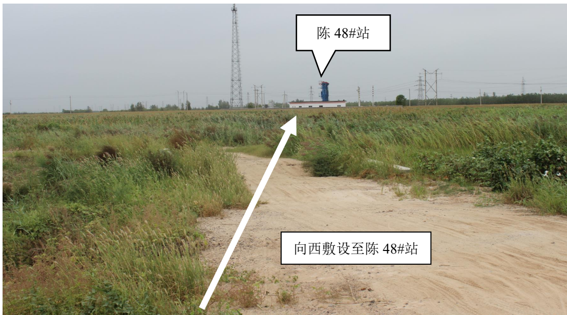
图 5.2-5 陈西接转站至陈 48#站掺水管线现场图 3
