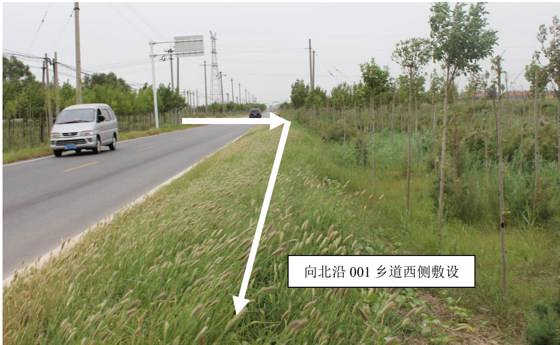
图 5.2-4 陈西接转站至陈 48#站掺水管线现场图 2
