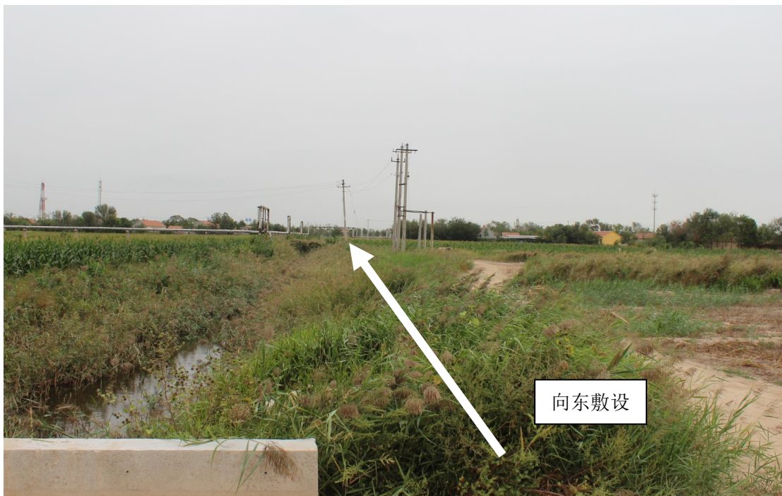
图 5.2-7 陈 39#站至陈 36#站掺水管线现场图 2
