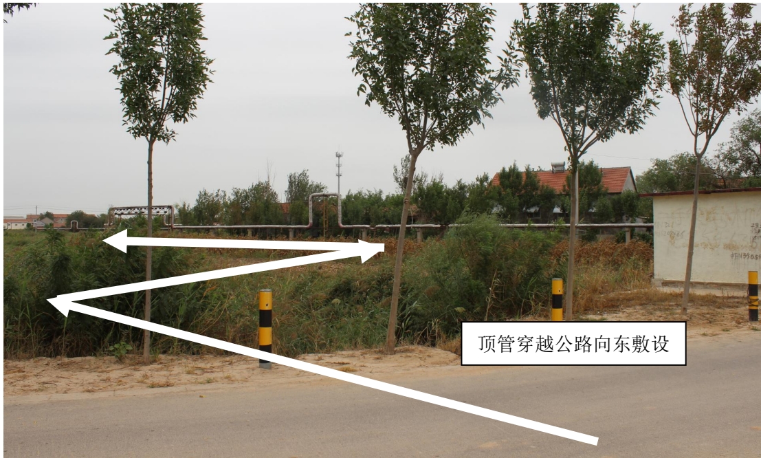
图 5.2-8 陈 39#站至陈 36#站掺水管线现场图 3
