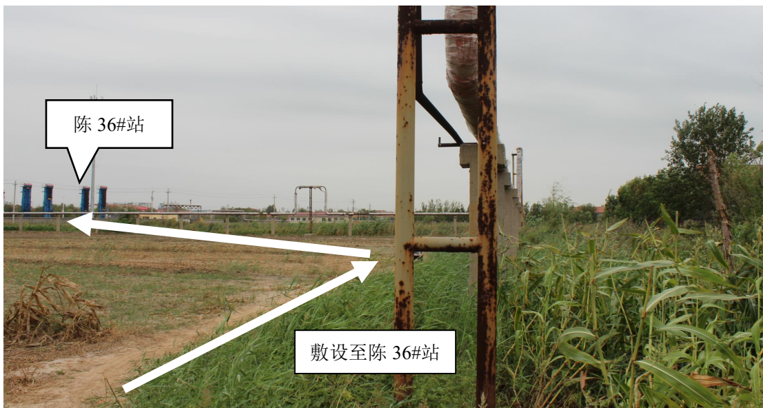
图 5.2-9 陈 39#站至陈 36#站掺水管线现场图 4
