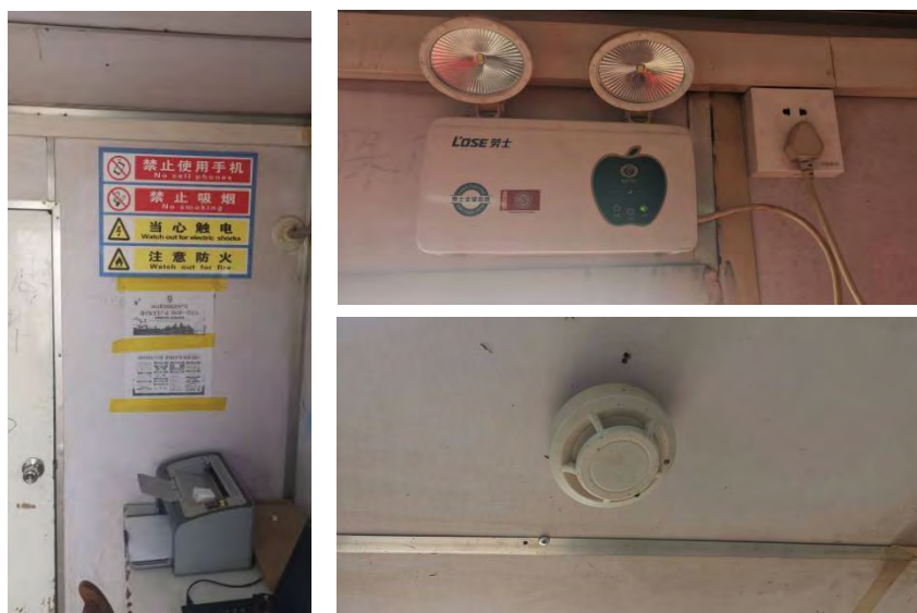
图 5.1-9 现场安全设施
