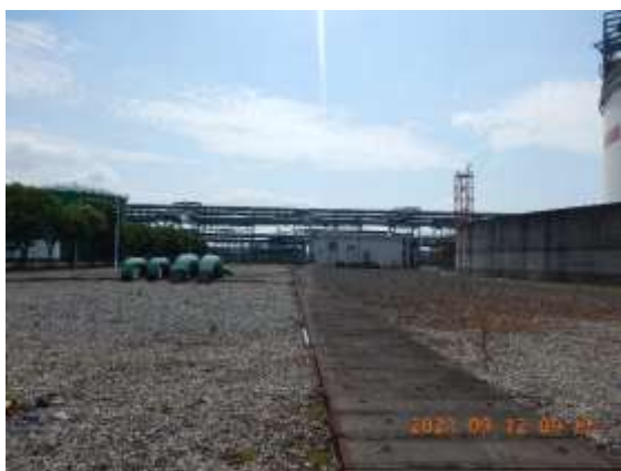
南侧的厂区围墙
